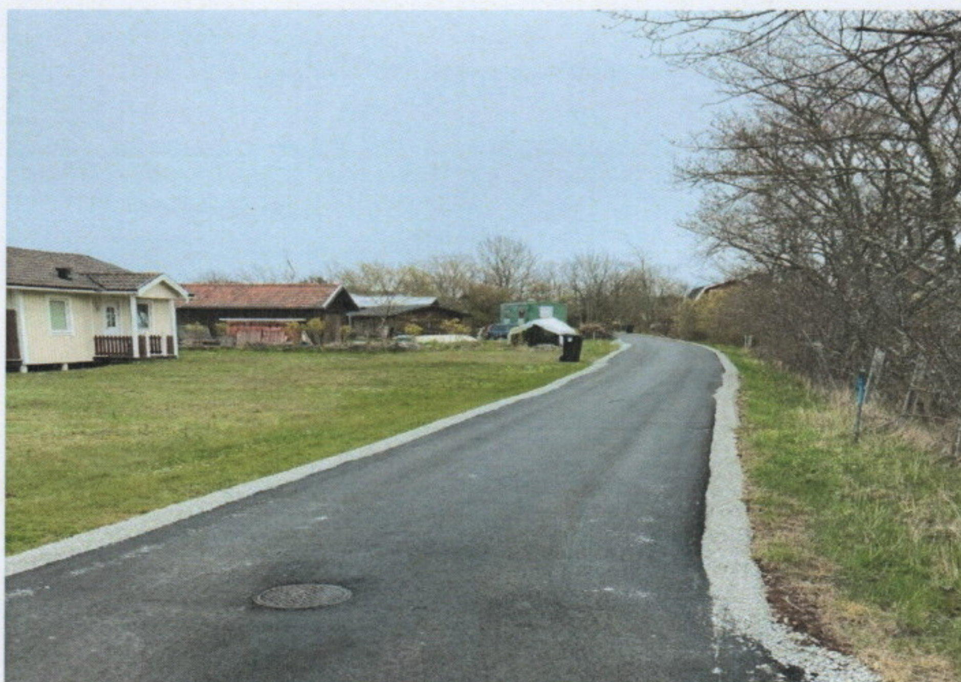
Asfalt på Brokvägen.
