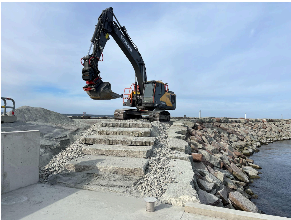
Kommunen reparerar stormskador på södra piren.
