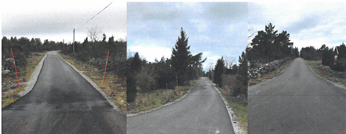
Fiskväg norra delen, Flundrevägen och Utmarksvägen
